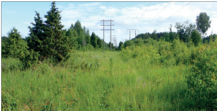
Kraftledning i Marma vid Älvkarleby.
